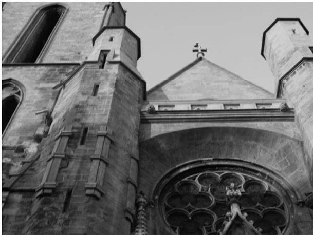
*Illustration 3 : les parements de toiture sont restaurés, le corps inférieur des tourelles et le bas de la façade mériteraient quelques soins urgents (photos été 2005)*
